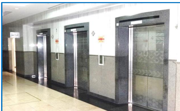
エレベーターホール①
