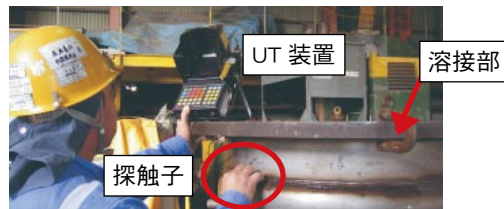
図5 超音波探傷試験
