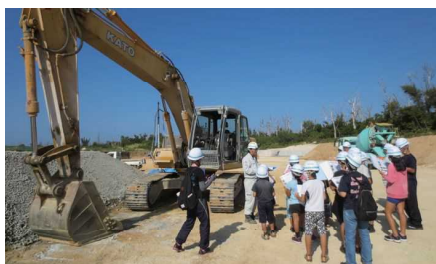
津堅地区2号貯水池 津堅小中学校現場見学会
