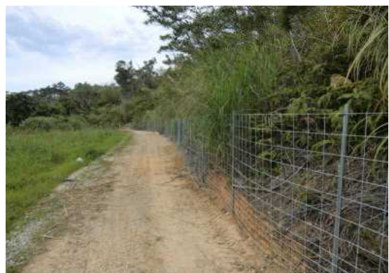
イノシシ侵入防止柵
