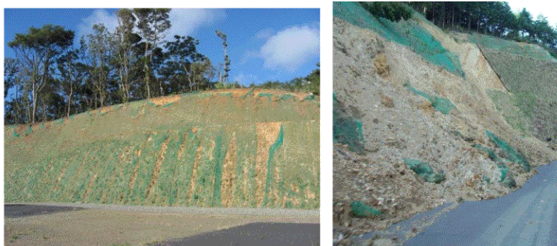
図2-5 法面緑化を図るが定着に至っていない例
