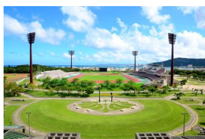
【陸上競技場全景】
