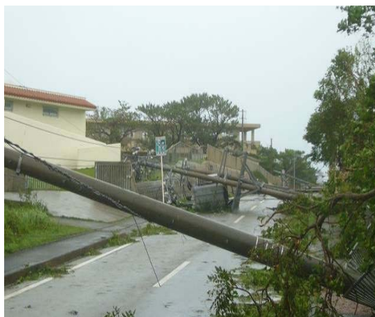
図 2-2 平成 18 年 台風 13 号 (石垣市)
