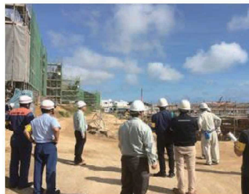
建築パトロールの状況
