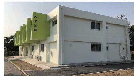
八重山農林高校寄宿舎改築工事
