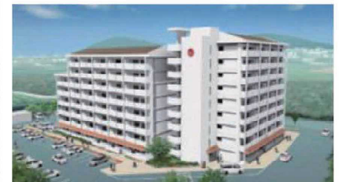
県営新川団地建替工事
