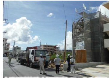
↑違反建築防止週間パトロールの様子
