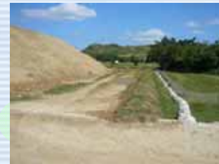
小提工と土のう工 (表面流出抑制工)
