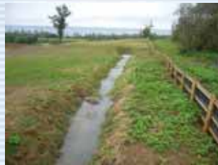
切り回し水路 (水路流出抑制工)
