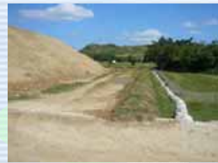
小提工と土のう工
