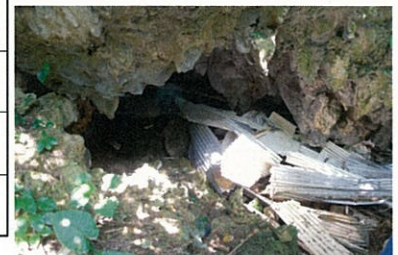
No. 39 洞口周辺状況 (平成 22 年 3 月 撮影)
