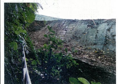
No. 11 洞口周辺状況 (平成 22 年 3 月 撮影)
