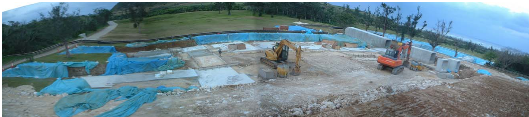
図 2.4.2(1) 人工洞設置状況
