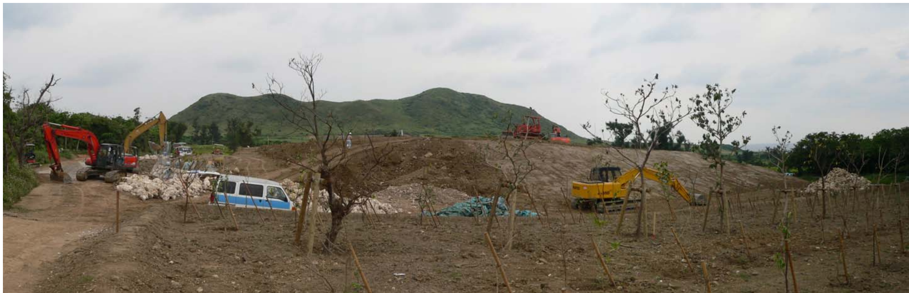
図 2.4.2(3) 人工洞設置状況
