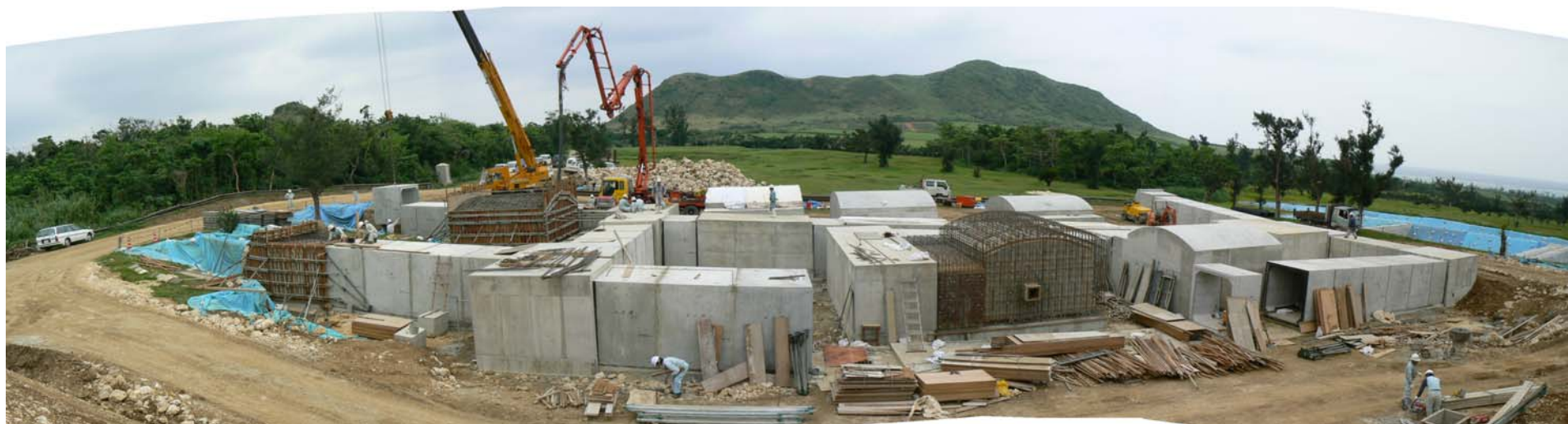
図 2.4.2(2) 人工洞設置状況
