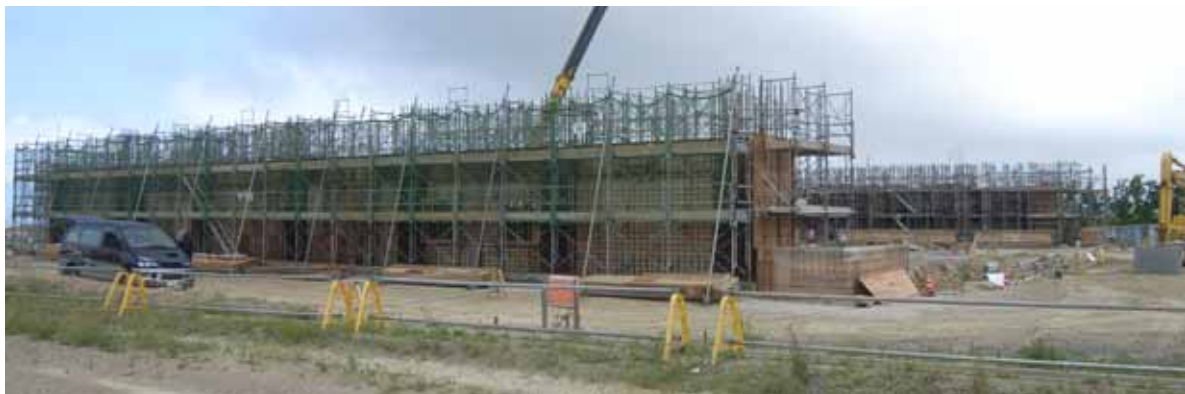
図 1.13.2 海上保安庁庁舎建築の現況写真（平成 24 年 5 月）
