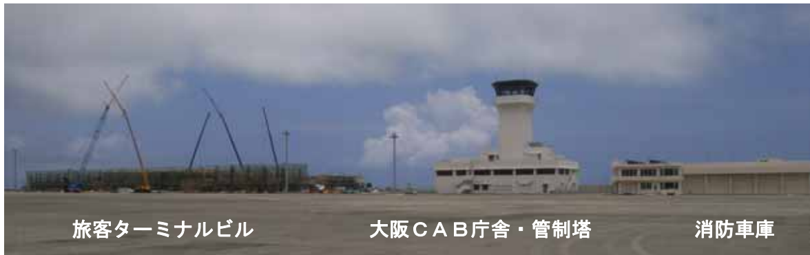
図 1.13.1 旅客ターミナルビル等建築の現況写真（平成 24 年 5 月）
