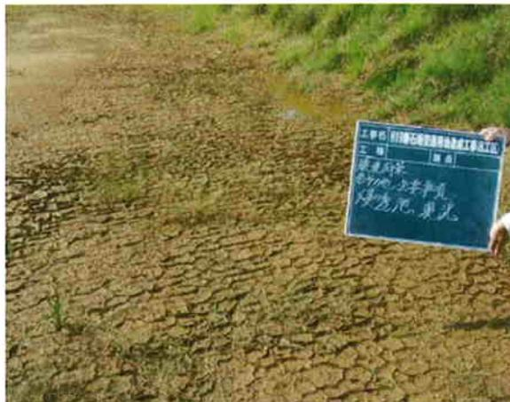
浸透池降雨後の微粒子土砂堆積状況
