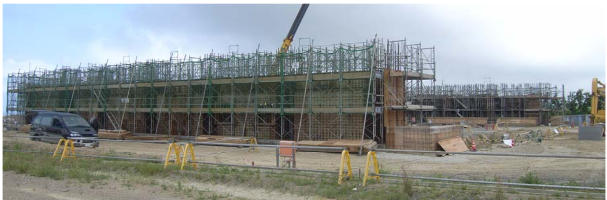
図 2.13.2 海上保安庁庁舎建築の状況（平成 24 年 5 月）
