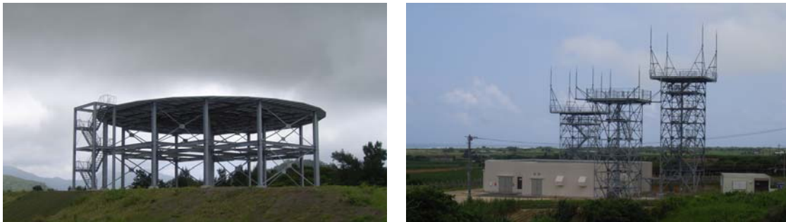
図 2.12.1 施設建築状況（左：VOR/DME 施設、右：TSR 施設（平成 24 年 5 月））
