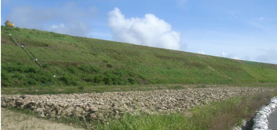
図 3.11.1 法面植栽現況写真(平成 23 年 7 月)
