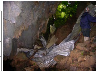
No. 39 洞口周辺状況 (平成 21 年 1 月 撮影)
