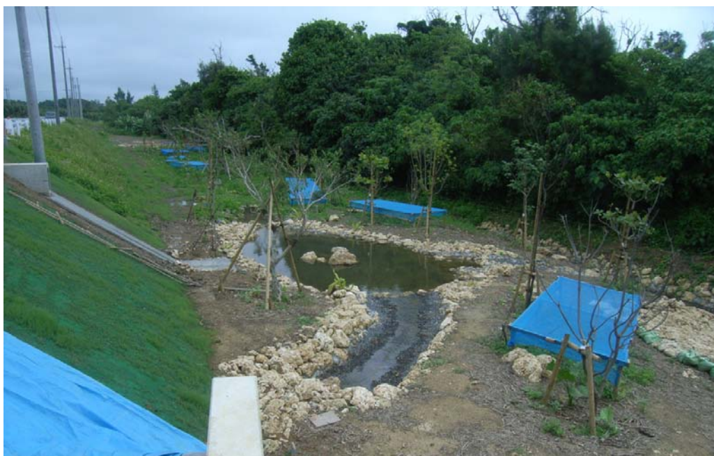
図 2.11.1(2) 第1ビオトープ現況写真
