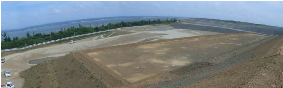
図 2.3.2 築堤による貯留容量の確保
