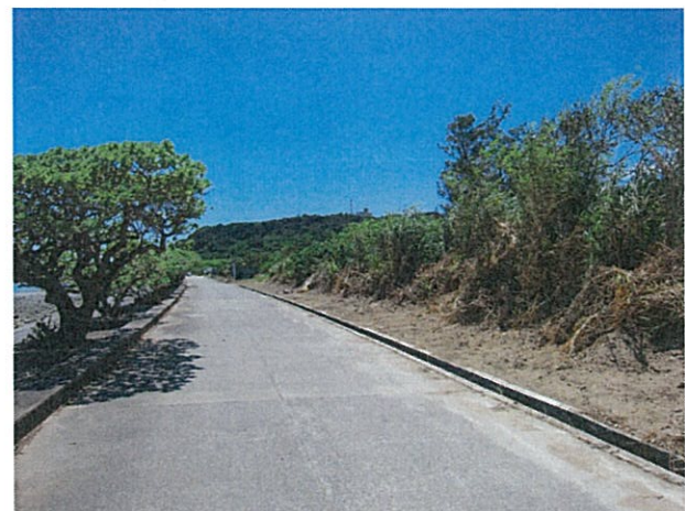
防風林周辺の草木伐採完了状況 （北東側から撮影）
