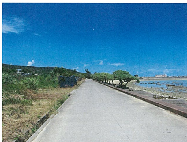
道路や排水溝、護岸もきれいになりました。 (南西側から撮影)
