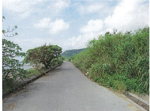
防風林周辺の草木繁茂状況（北東より） 道路まで草がせり出していました。
