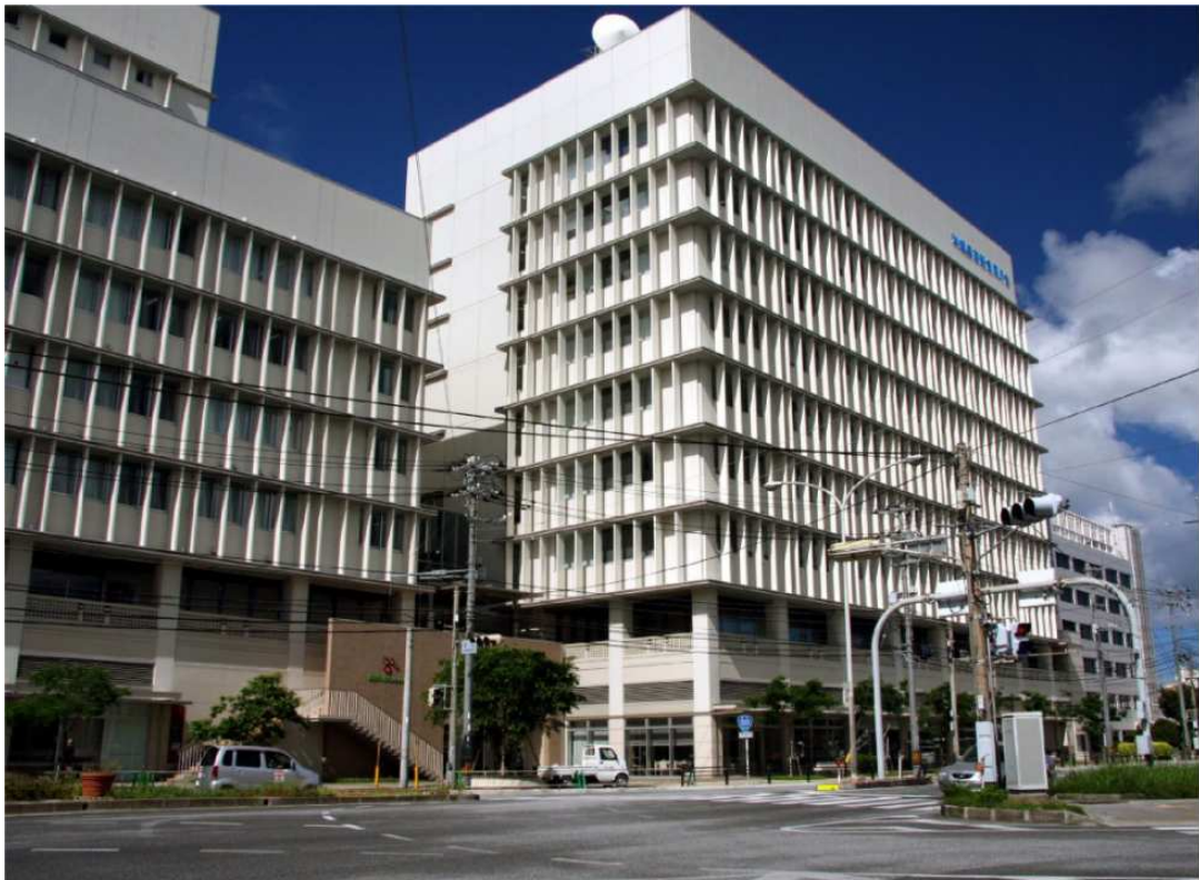
沖縄県南部合同庁舎
