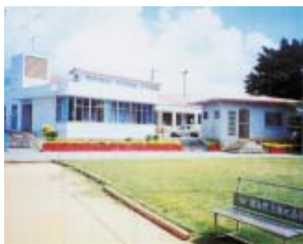
多目的集落施設
