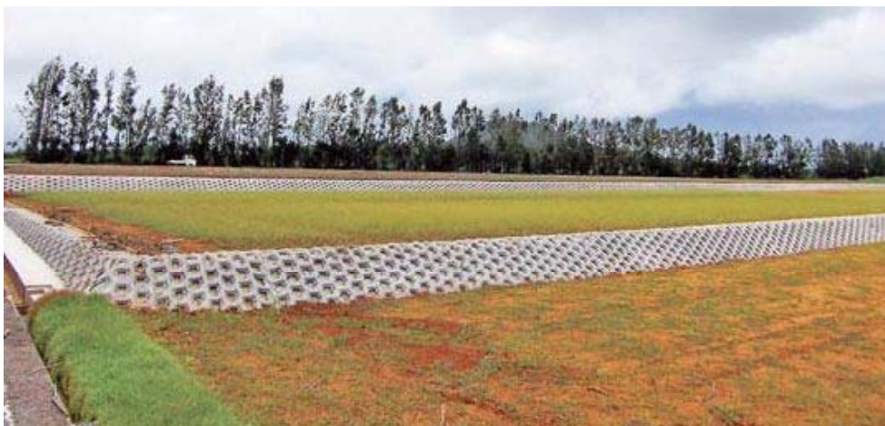
勾配抑制工施工後の農地
