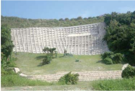
地すべり対策事業（法面保護）
