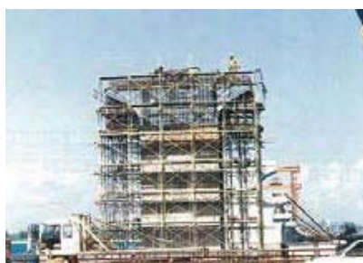
躯体立上りの施工
