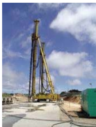
止水壁工事 (SMW工法)
