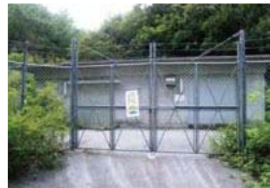
鍋川揚水機場
