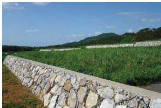
整備後のほ場（勾配抑制）水質保全対策事業（本部町）
