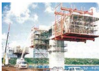
航路部の施工
