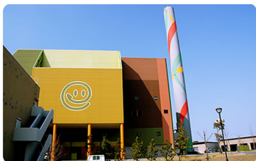
○ごみ焼却施設
