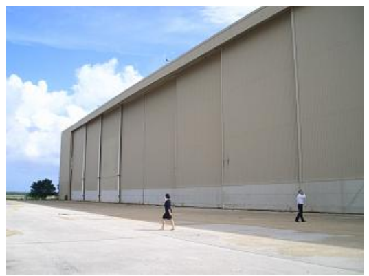
緊急物資保管倉庫
