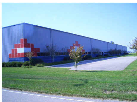
駐機施設（現在は倉庫）
