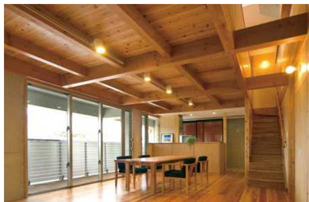
鉄筋コンクリート造のスケルトンに木造のインフィルを組み合わせてある
