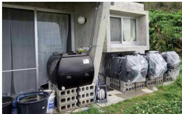
屋上緑化雨水循環システム
