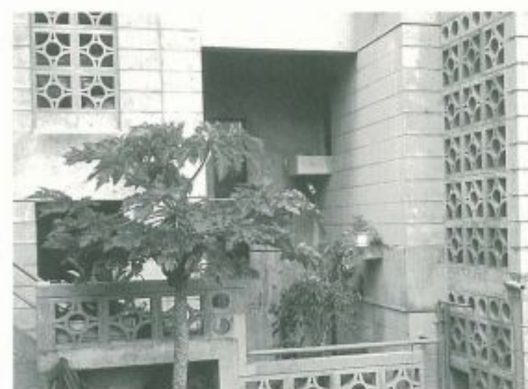
花ブロック…日ざしをさえぎりながら風を通す部材として使用されています。
