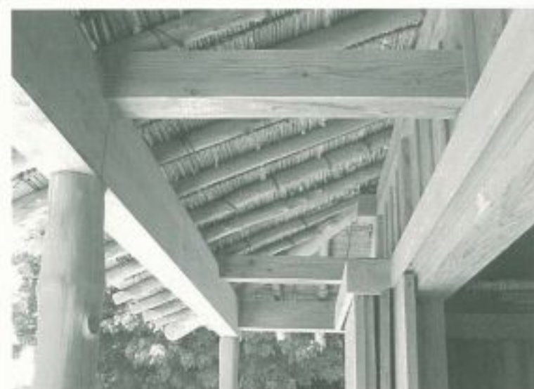
木 材…地場産のチャーギ（イヌマキ材）を使用したアマハジの軒裏の仕組。
