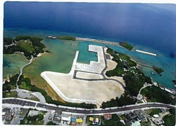
水産物供給基盤整備事業 瀬良垣漁港(H21完了)
