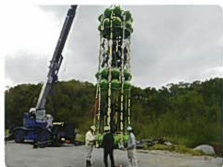
伊平屋西地区(H22完成)『浮魚礁(バヤオ)』
