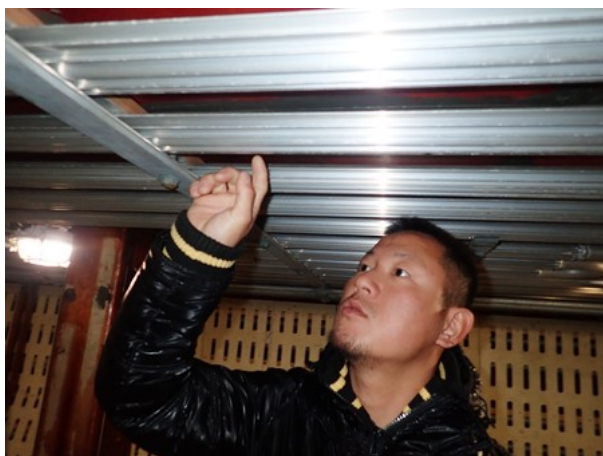
中型イカ釣り船急速凍結冷凍庫内。上部はアルミにて冷却
