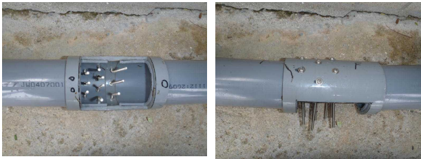
⑥異物除去器F（勝連式②VP65ジョイントステンレスネジ4mm×10）
