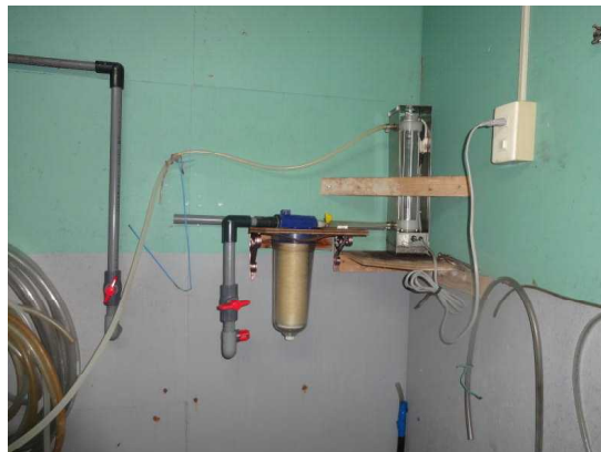
図1 濾過フィルターと紫外線殺菌装置
