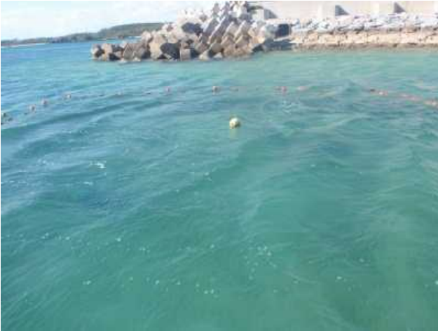
漢那地先のロープ設置区
