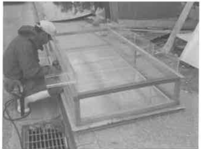
宮古式洗浄機の枠を作成
