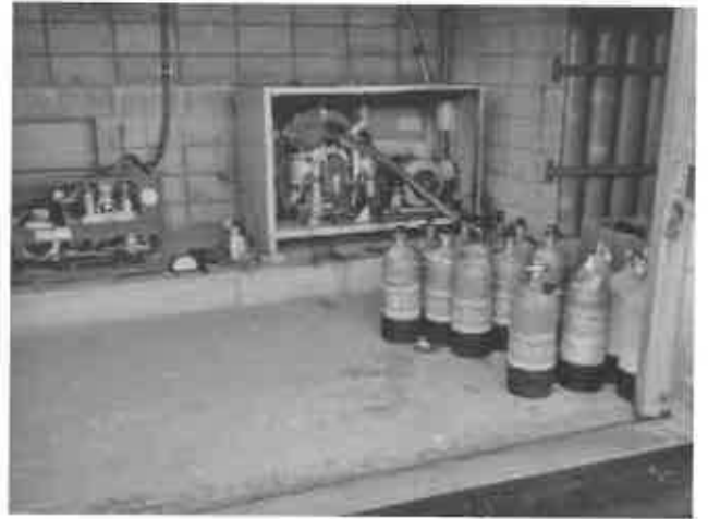
タンクへのコンプレッサー
