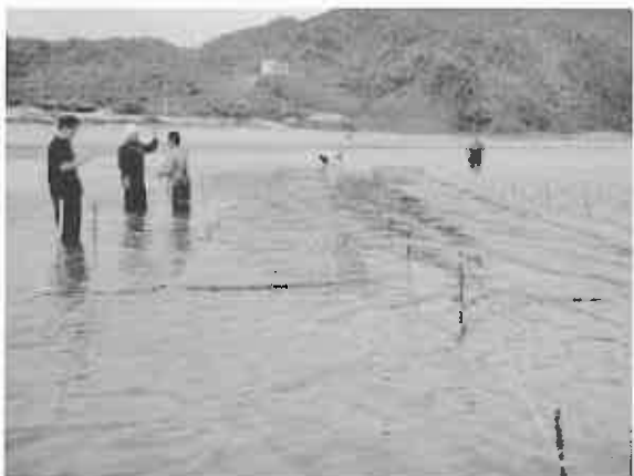
(23) 2月8日 比川地先本張り作業
