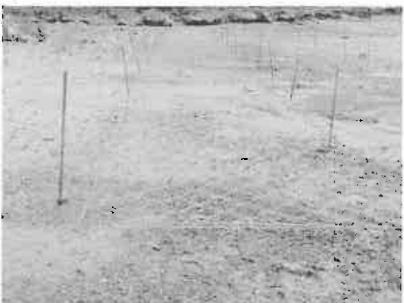
(24) 3月18日 上地地先本張り後
