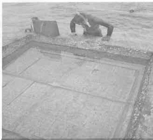
図6. 食害防止網および基盤設置状況
