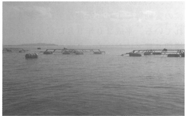
生け簀設置作業
