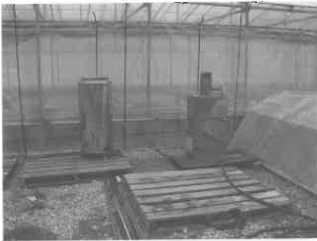
図-15 灯油ボイラーの取り付け
