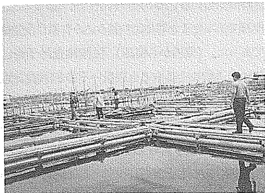
屏東縣東港在にある入り江 慶宏水産股份有限公司の養殖生け簀施設群
