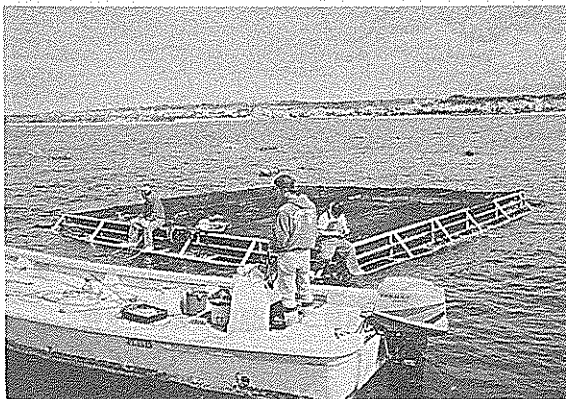
読谷村都屋漁港から沖合い沈下式生 け簀施設に曳航し設置終了
