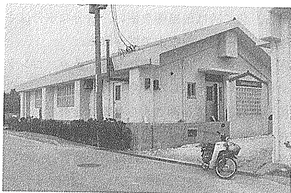
②平成8年3月竣工加工場
