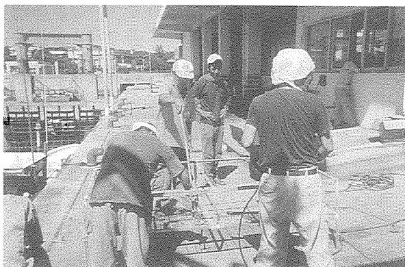
H14.9.4ケージ作製（枠の溶接作業）
