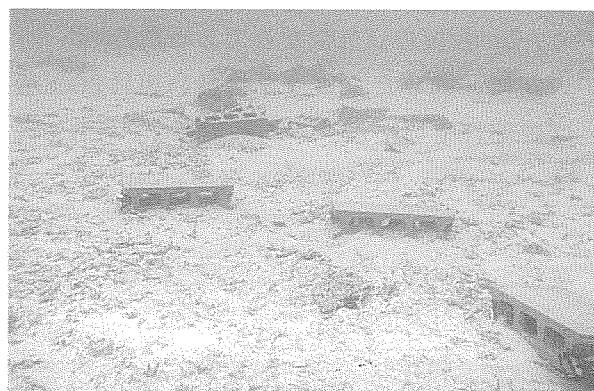
台風で散乱・埋没したブロック
