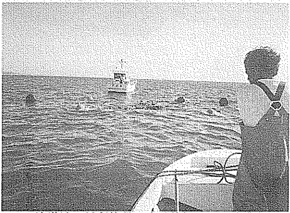
漁港沖の係留施設で生け簀網の設置作業
