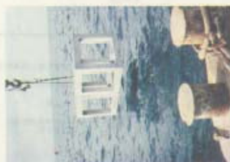
⑦ 沈設位置の標識旗を船の中心に投入する
