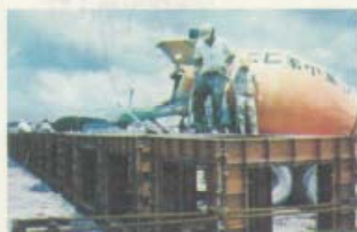
② 生コン車で型枠内にコンクリートを流し込む
