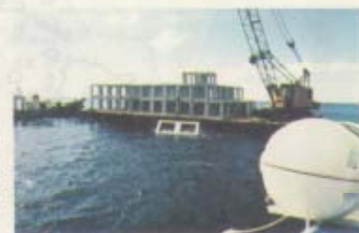
⑧ 台船から重機で沈設作業
