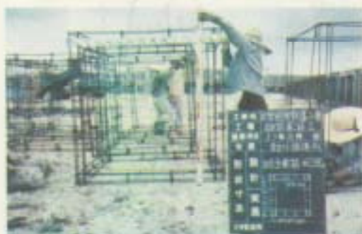
① 鉄筋組立て
