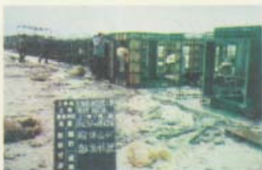
③ 鉄筋組立てと型枠の解体
