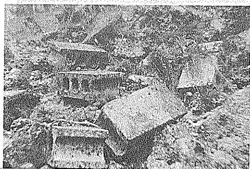
⑤ 1977年2月8日 根石 (縦3.4 m × 横2.2 m × 1.3 m) の上に設置したブロック。ブロックと岩礁の表面はホンダワラ幼芽が密生している。(前兼久)
