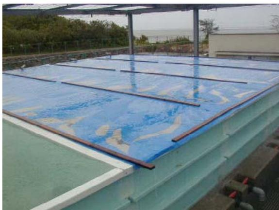
写真 1. シートを用いて台風対策を施した水槽
