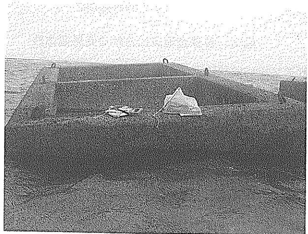
写真2. 波浪による育成礁の移動と傾き
