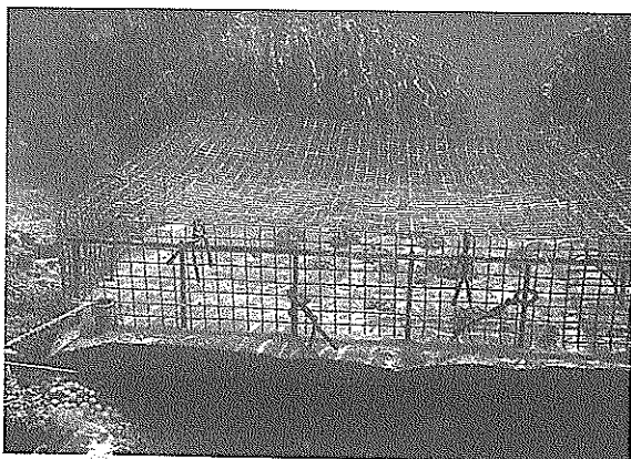
写真1. 金網付きコンクリート板
