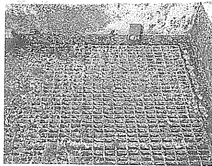
写真2 FRPグレーチングの設置状態 Photo.2 FRP grating in the nursery.
